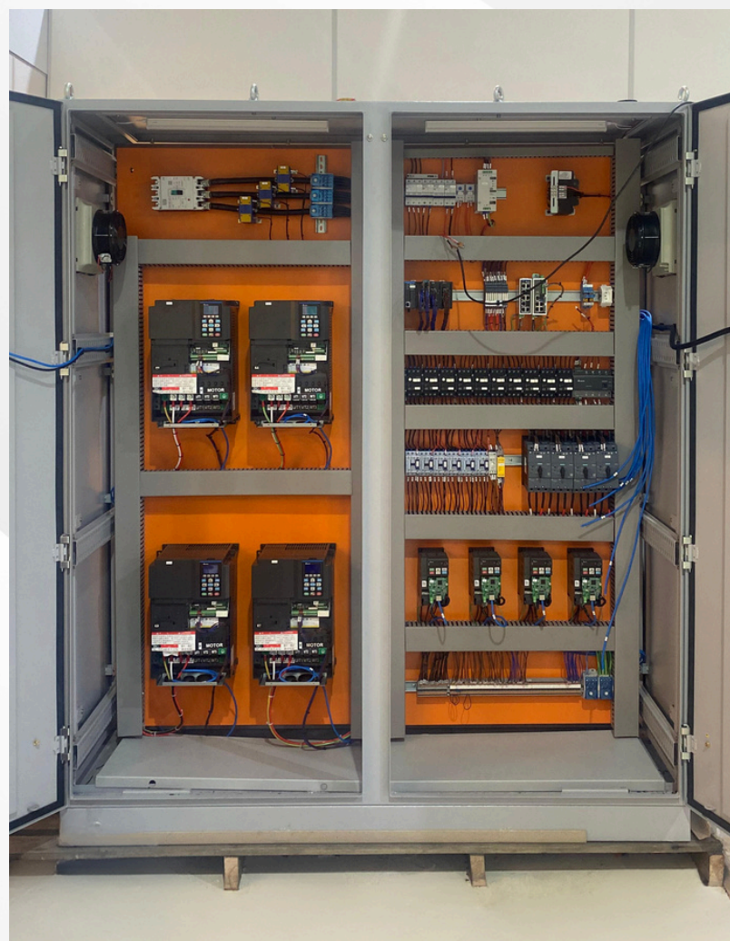
Painel de Automação para Controle de Sistema de Secagem em Indústria Madeireira.
